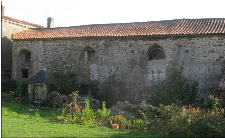
Le côté nord de "la collégiale Saint-Maurice" dans son état de 2016 : avec deux de ses baies extérieurement en ogives.
