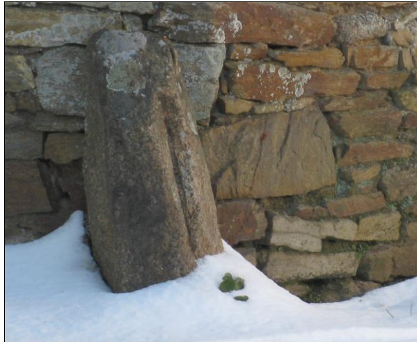
Chasse-roues dans la "rue des Jardins", la possible ancienne "rue du Jardinet", en février 2012. Dans les années 2000, des bornes ont été posées à certains coins de rues anciennes de Montaigu, reprenant l'usage de ces anciens chasse-roues qui étaient destinés à protéger les angles de maisons des frottements des véhicules.
