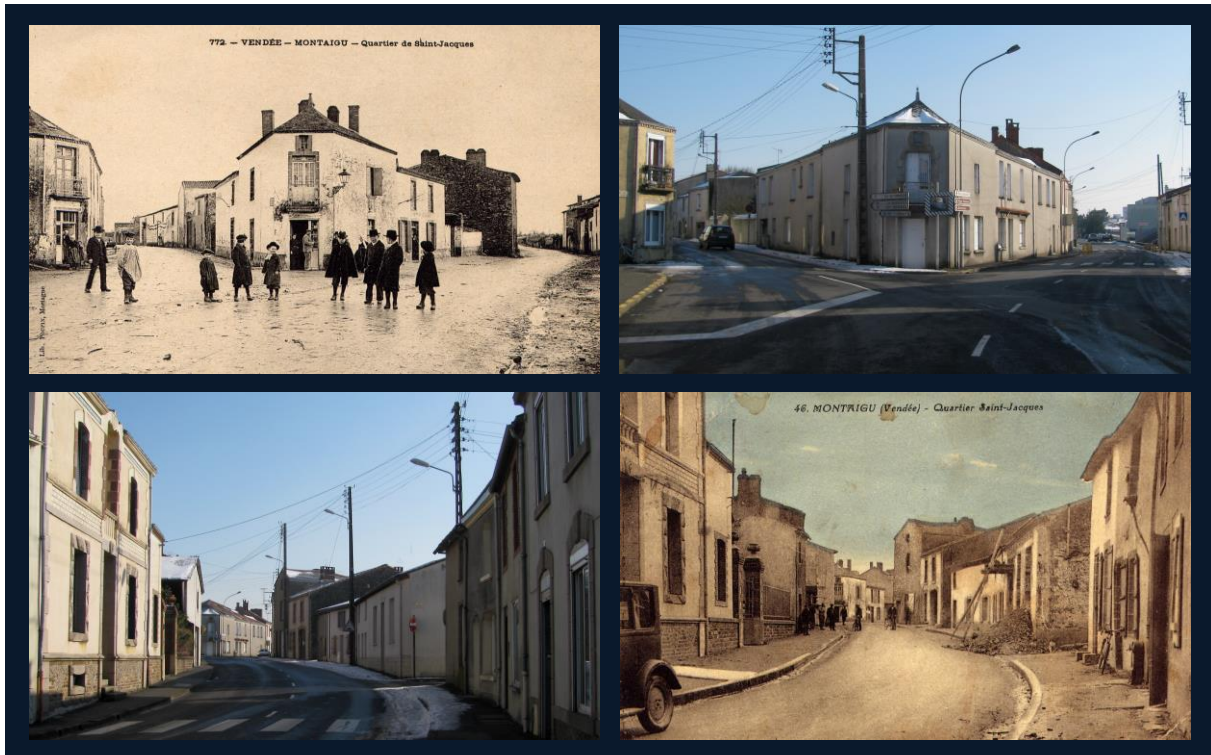
Le "faubourg Saint-Jacques" : l'embranchement des routes de la Boissière et de Saint-Georges en 1905 et durant l'hiver 2012, la "rue Saint-Jacques" durant l'hiver 2012 et en 1935.
