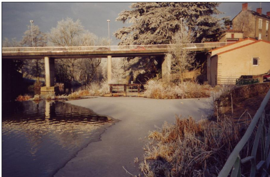
Le "pont Saint-Nicolas" avant et après l'intervention, en 1979/1980, de Robert Thomas (photo, © mairie de la Chevrollière), chef des Ponts et Chaussées, et initiateur de la destruction du pont médiéval de Montaigu.
